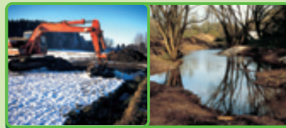
Zwei Gestaltungsbeispiele: Links, Aufweitung eines Grabens und rechts, Kleinwehler nach Vorbild eines Altwassers.
